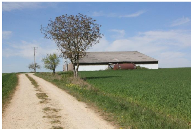
Photo 7 : Ligne électrique 20 kV desservant le hangar agricole au sud de l'aire d'étude
