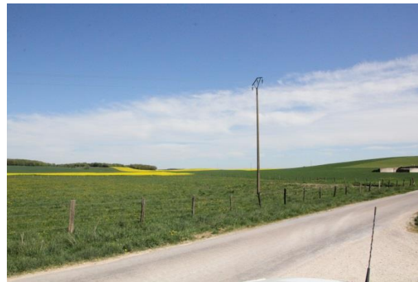
Photo 8 : Ligne électrique 20 kV à proximité de Mirbel
